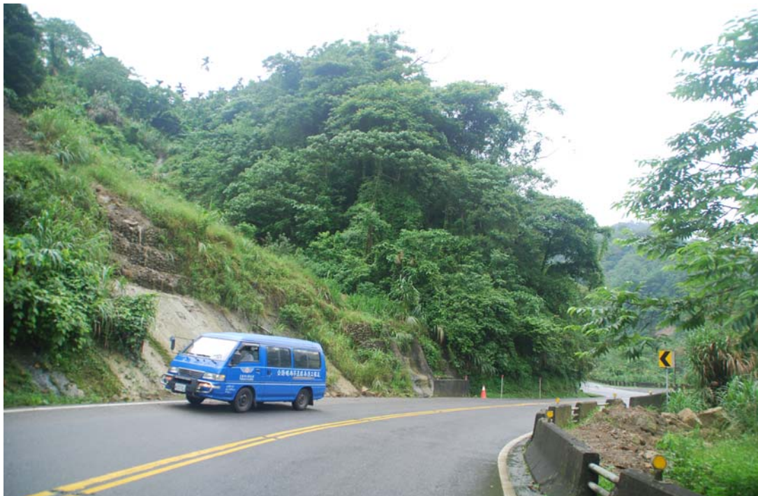
圖 5-2-10 阿里山公路 38k+700 在 2013 年 05 月 17 日邊坡崩塌礫石暫置放下邊坡護欄外與上邊坡二沖蝕溝匯流合一實況圖(賴明煌拍攝)
