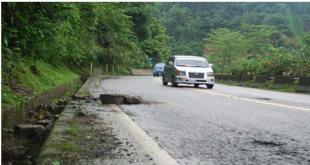
圖 4-3-1-2 阿里山公路 37k+100 在 2013 年 05 月 17 日 11 時的零星小崩塌落石已略妨礙正常行車而轉駛入逆向車道之情況。(賴明煌拍攝)
