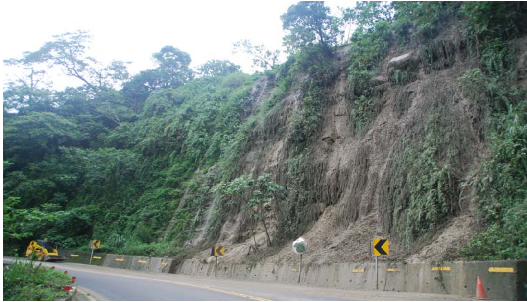
圖 5-2-7 阿里山公路 39k 在 2013 年 05 月 17 日 15 時 30 分邊坡崩塌泥流現場搶機具山貓鏟刮其崩塌泥流與當場戒護作業實況圖(賴明煌拍攝)
