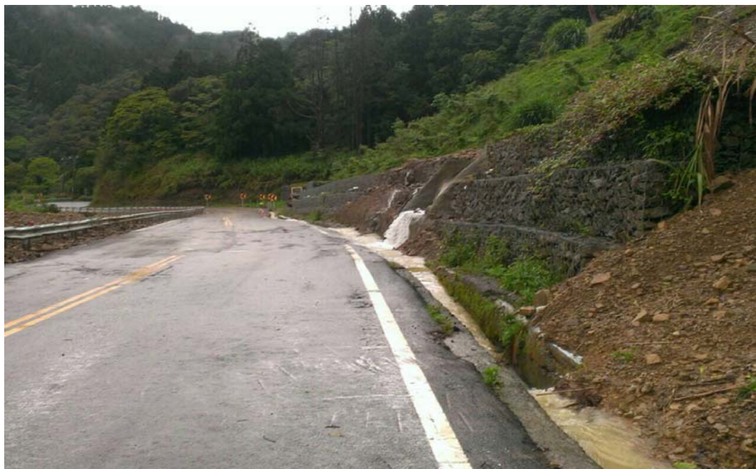
圖 5-2-4 阿里山公路高海拔 82k+500 於 2013 年 05 月 19 日受豪雨誘發崩塌岩土泥塊已清理完畢通車的現場施工後實景圖(黃坤森當日 16 時拍攝)
