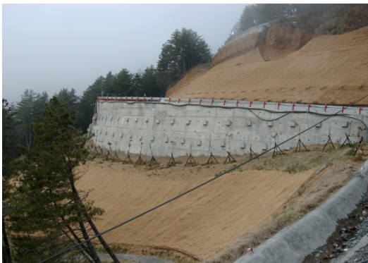
圖 11 41K 邊坡噴植完工 (2004/2/20)
