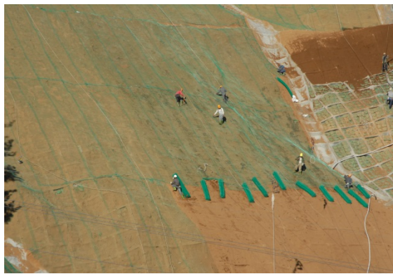
圖6 台14甲41.2K型框植生護坡工法 (2009/12/3)
