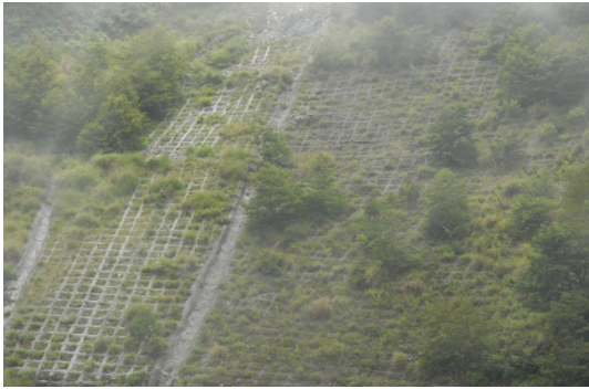
圖 19 台 8 線關原橋附近邊坡植生 (2009/6/20)
