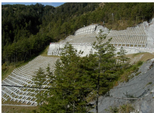
圖5 台14甲41K格梁地錨工法(2003/11/1)
