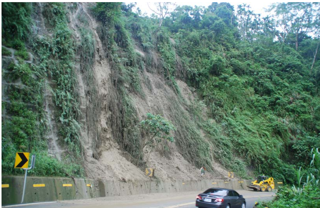
圖 5-2-6 阿里山公路 39k 在 2013 年 05 月 17 日邊坡崩塌泥流現場搶機具山貓鏟刮其崩塌 泥流施工作業中實況圖(賴明煌當日 15 時拍攝)
