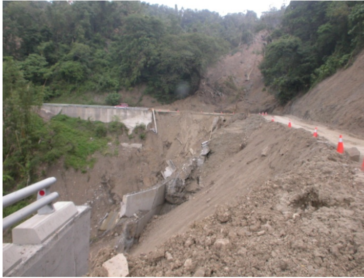
圖 8 地滑發生於剪裂帶構成的河谷終點
