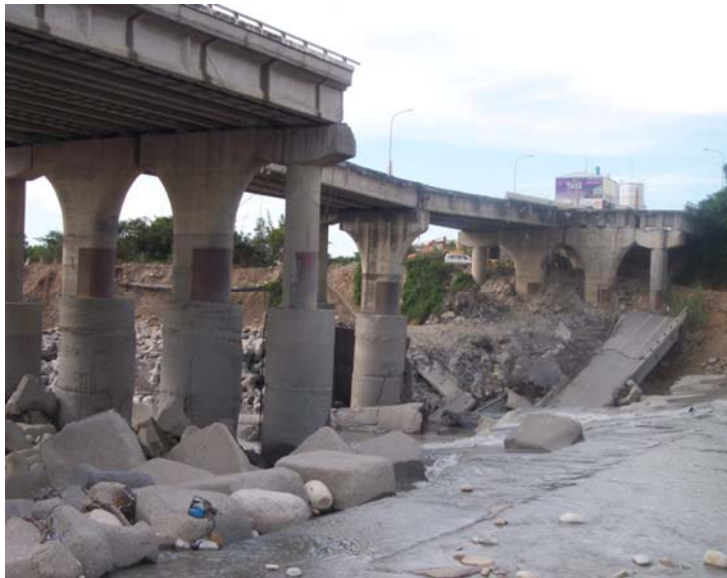
(c) 921 大地震後辛樂克颱風中落橋
