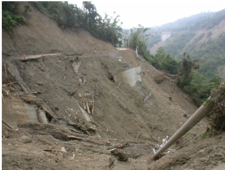
圖 9 地滑發生於剪裂帶構成的 S 型彎道
