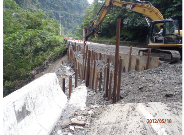
台9線 147K+050-施工中
