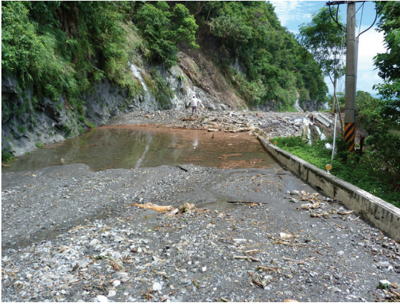
台9線 149K+300-施工前
