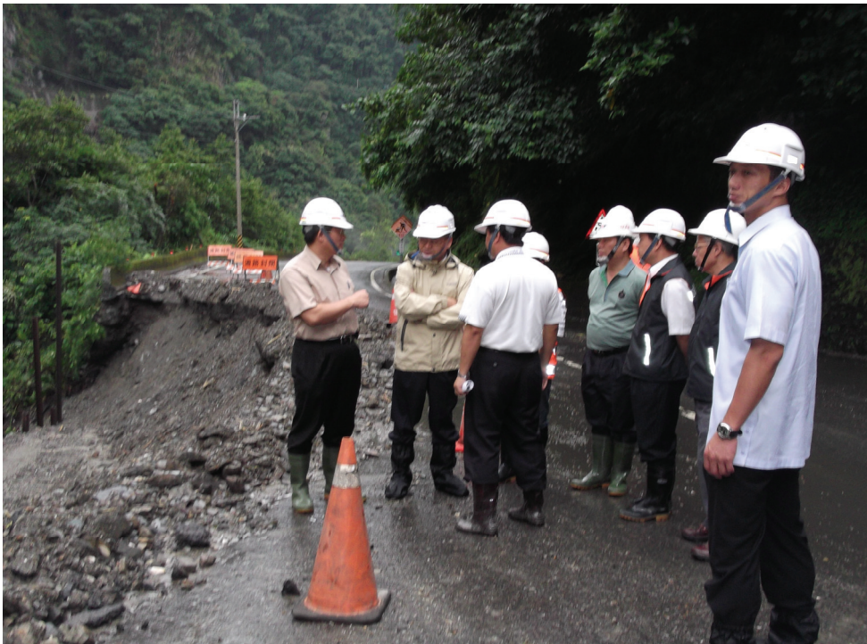
圖 4.9 交通部毛部長視察蘇花公路災修工區-2
