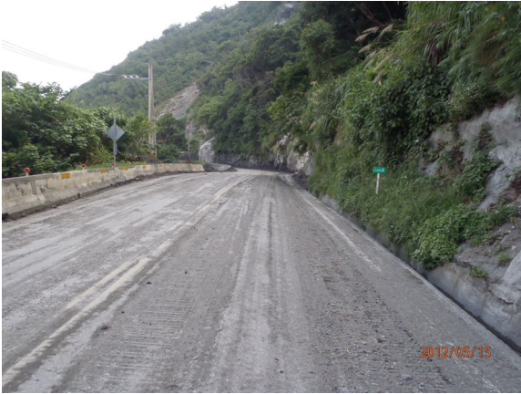
台9線 149K+300-施工中
