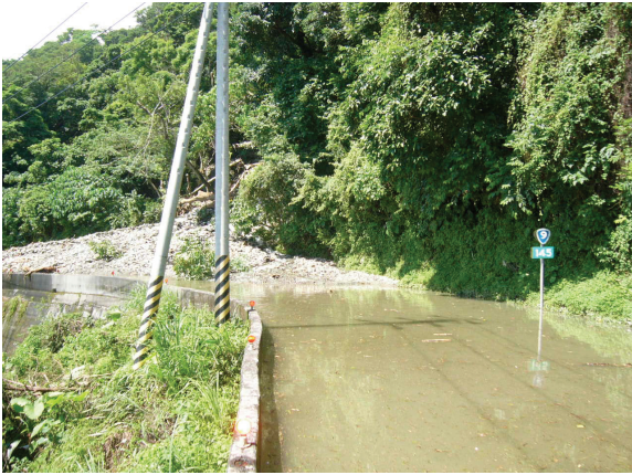
台9線 145K+000-施工前
