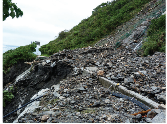
台9線 149K+400-施工前
