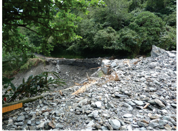
台9線 144K+750-施工前
