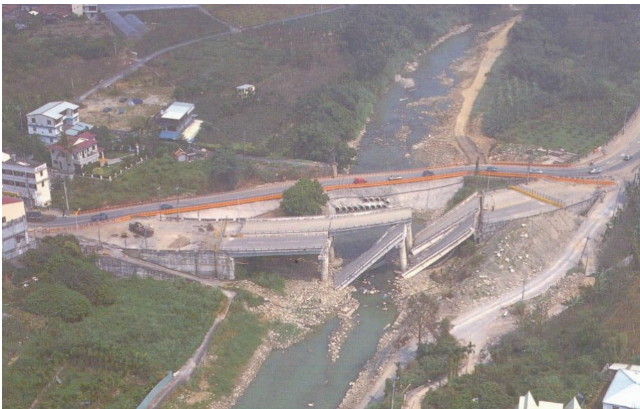
圖 3 石圍橋落橋後土堤便道完工時景況(參考文獻[1])
