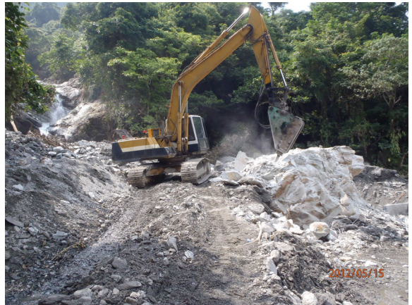
台9線 144K+750-施工中
