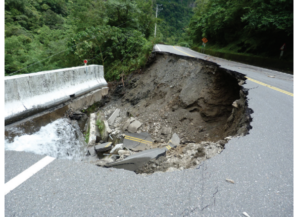
台9線 147K+050-施工前
