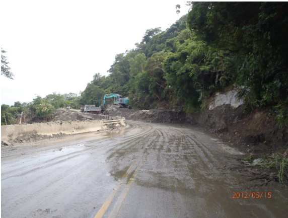
台9線 143K+800-施工中
