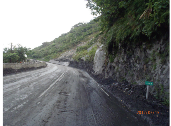
台9線 149K+400-施工中
