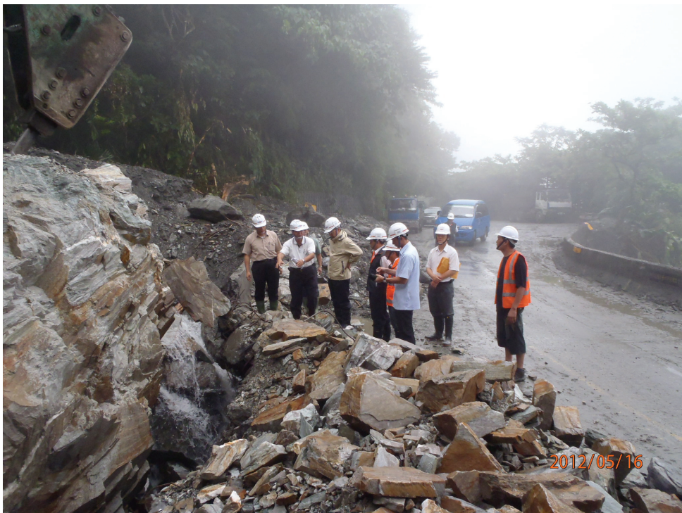
圖 4.10 交通部毛部長視察蘇花公路災修工區-3
