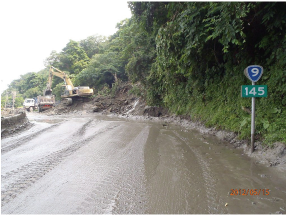
台9線 145K+000-施工中
