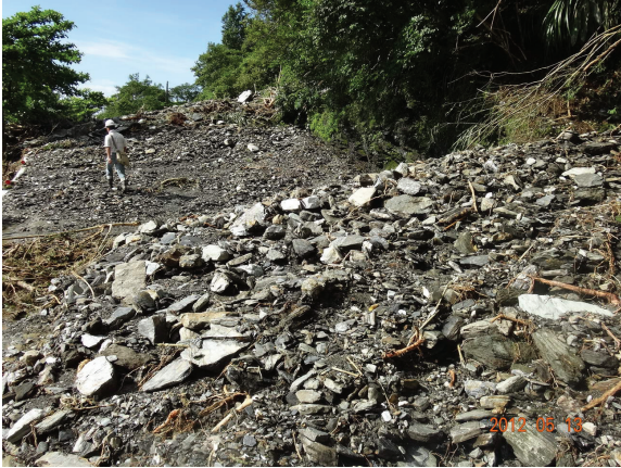
台9線 143K+800-施工前
