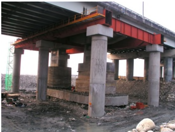
圖 1 臨時支撐鋼構架
