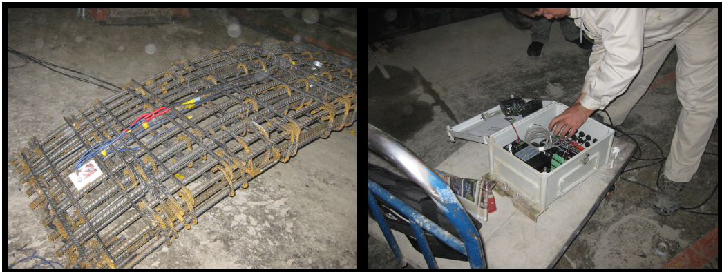
圖二 鋼筋計及鋼筋籠組裝完成及接線測試
