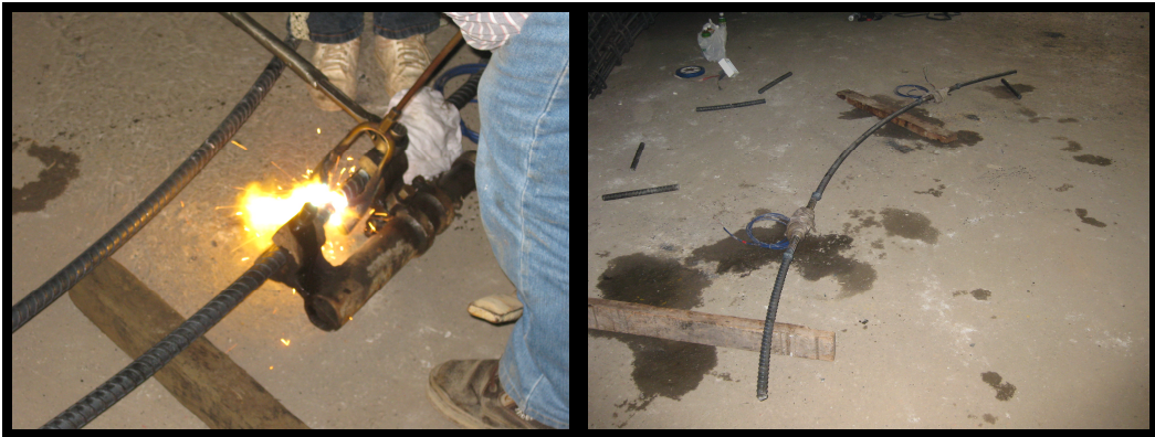
圖一 環片主筋與鋼筋壓接及壓接完成
