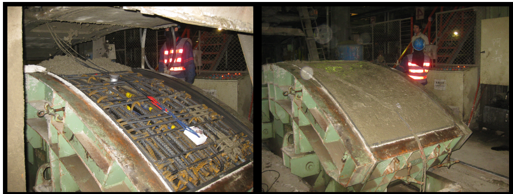
圖三 鋼筋籠置入鋼模內並澆置混凝土
