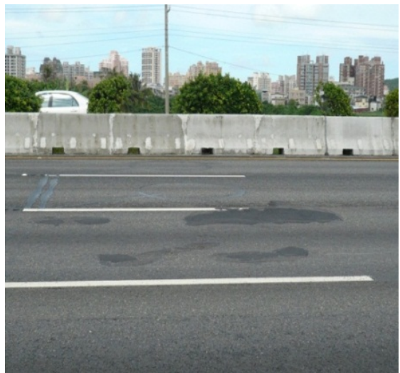
圖 2.1.4 第 3 車道坑洞修補
