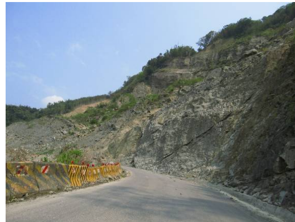
塊狀砂岩剪裂帶節理葉理密佈
