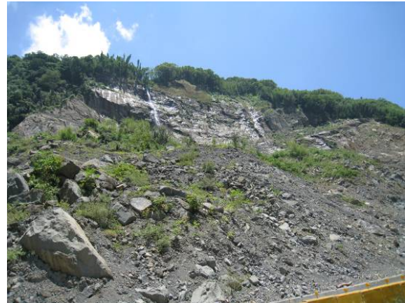
崩場地冠部向斜軸部形成雨瀑
