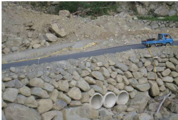
緊急搶通後重新埋設 RCP 管
