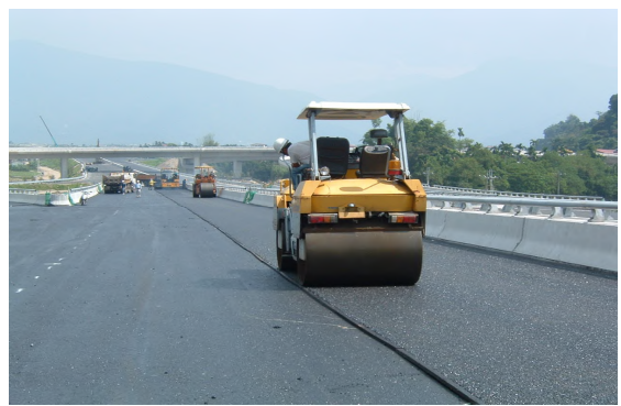
圖 17 終壓壓路機滾壓過程
