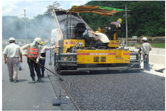
圖 13 PAC 拌和料倒入鋪裝機進料斗示意圖
