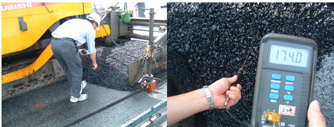
圖 14 施工現場之 PAC 溫度檢測
