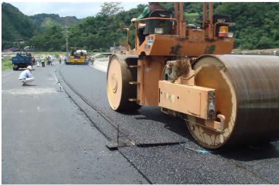
圖 16 初壓、複壓壓路機滾壓過程
