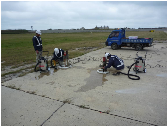
圖 23 灌漿孔位鑽設全景圖
