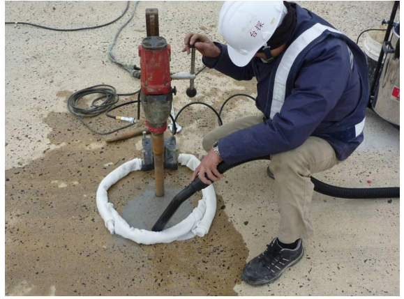
圖 22 灌漿孔位洗鑽
