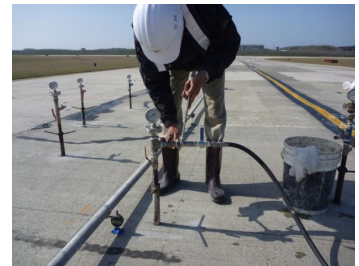
圖 30 灌漿管接上單 Packer
