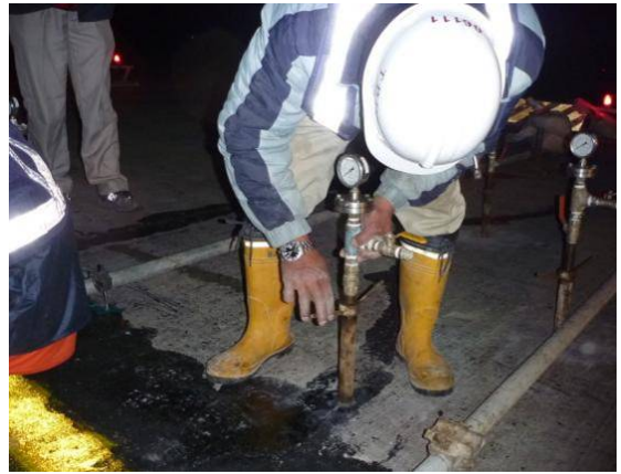
圖 24 灌漿孔位裝設單 Packer 及壓力錶
