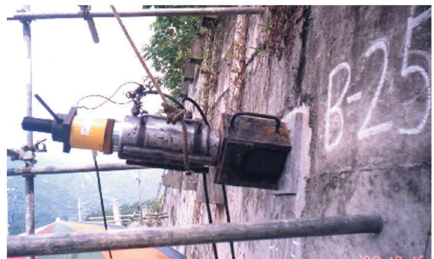
照片-16 B-25 地錨試驗情形
