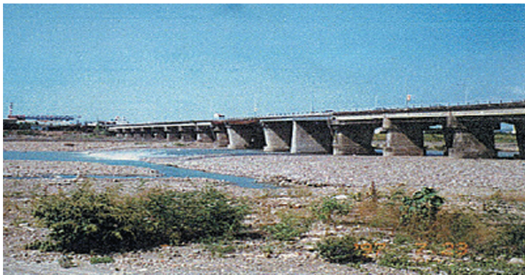
圖6 台一線頭前溪橋颱風受損復舊後情形
