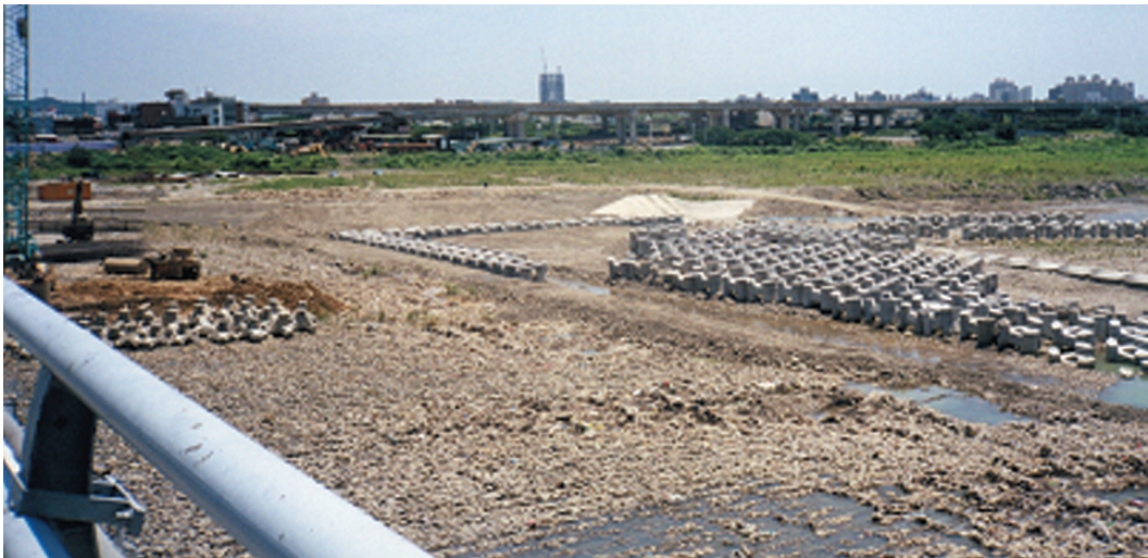
圖9 台一線頭前溪舊橋下游側低水槽固床工
