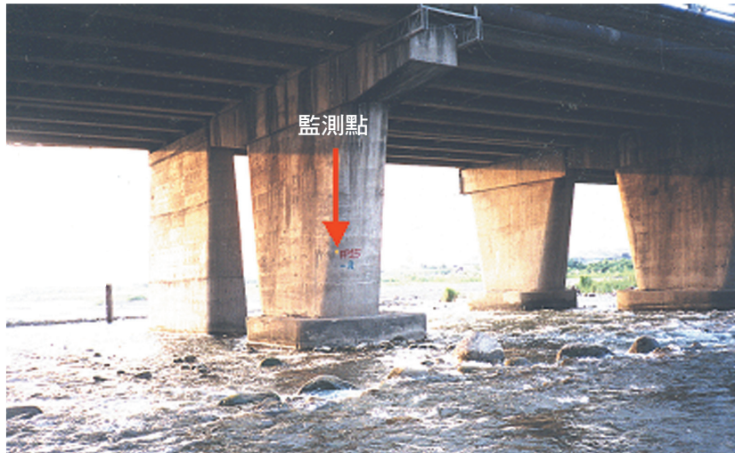
圖11 台一線頭前溪舊橋墩柱監測點
