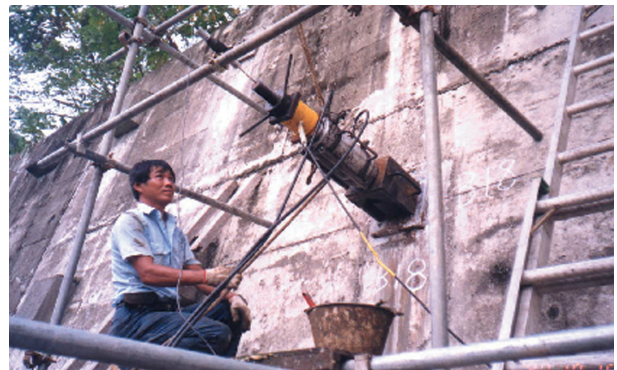
照片-14 B-18 地錨試驗情形
