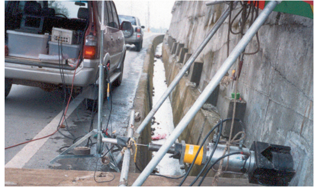
照片-10 F-46 地錨試驗情形
