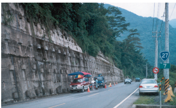
照片-3 道路拓寬預力地錨工程
