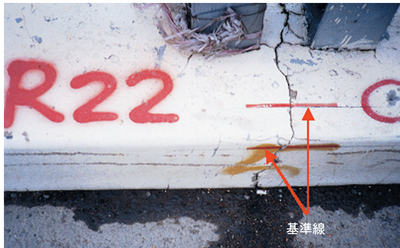
圖12 台一線頭前溪舊橋橋面版監測點
