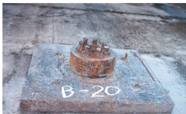
照片-6 B-20 地錨試驗情形
