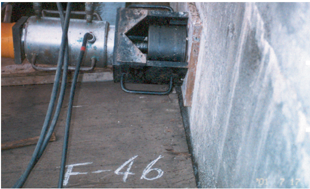
照片-11 F-46 地錨試驗完成後錨頭與承壓底鈹分離
