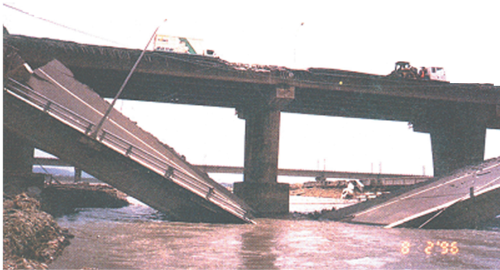
圖4 台一線頭前溪橋賀伯颱風受損情形
