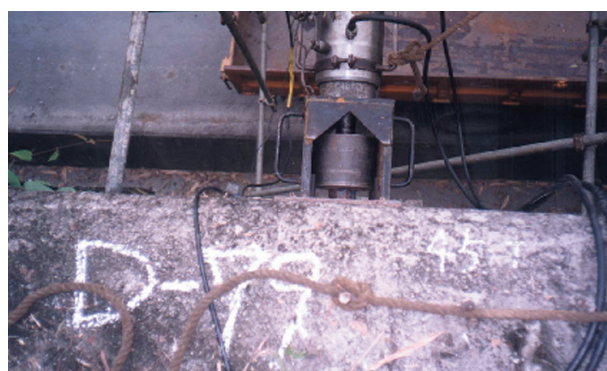
照片-8 D-79 地錨試驗情形
