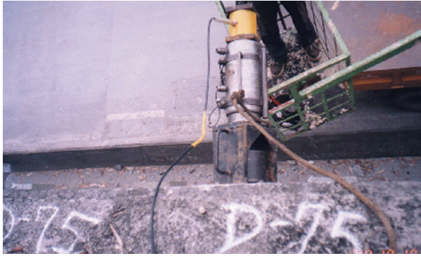
照片-17 D-75 地錨試驗情形
