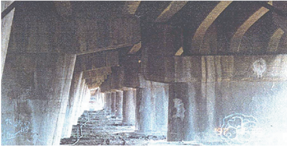
圖8 台一線頭前溪舊橋下部結構情形
