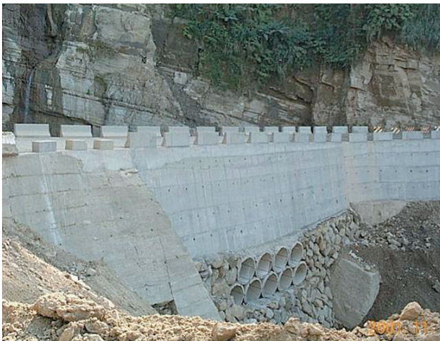
圖86 149 甲線雙孔橋以涵管便道搶修
