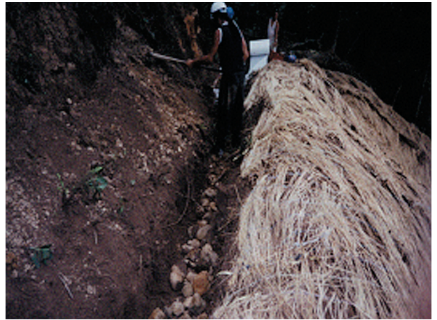
照片六 坡頂蝕溝人工處理
