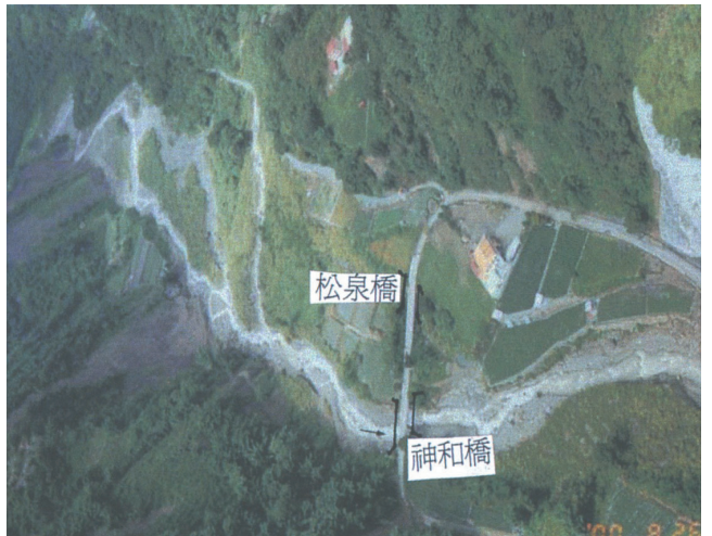
圖43 台21線松泉橋、神和橋（空照）
