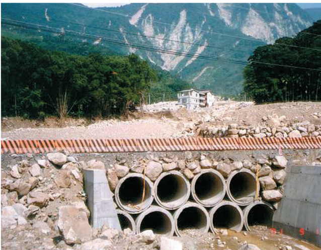
圖03 桃芝風災過後緊急搶通的郡安便橋
