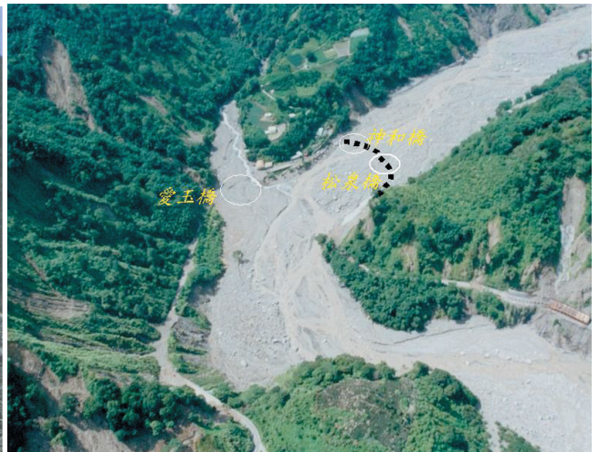
圖45 台21線松泉橋、神和橋遭土石流沖失，愛玉橋遭土石流掩埋（空照）
