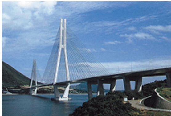
圖10 世界第一長三跨連續鋼斜張橋（多多羅大橋、中間跨距890m）
