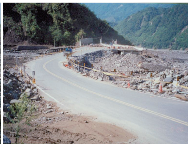
圖12 台21線信義橋溪底便道
