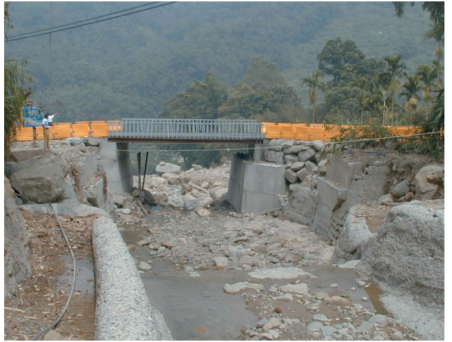
圖109 147線無名橋原橋址處架設鋼便橋
