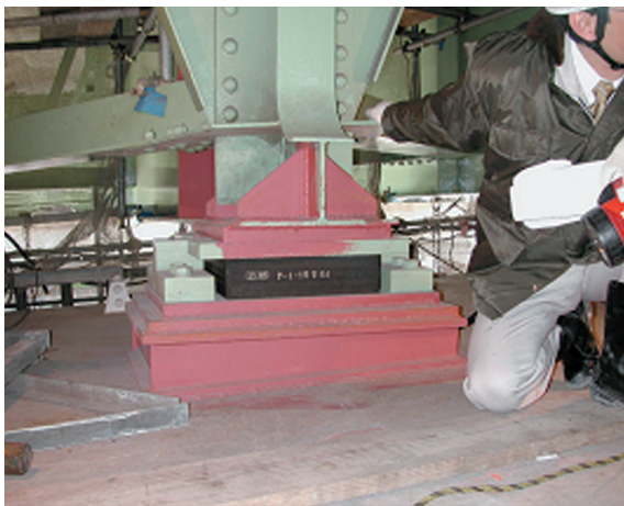
圖7 隔震支承——安裝後 (3)
