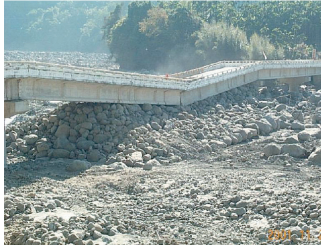
圖91 149甲線全仔社橋橋下填塞石塊搶修
