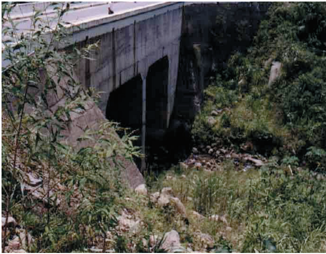
圖84 149 甲線雙孔橋原橋照片
