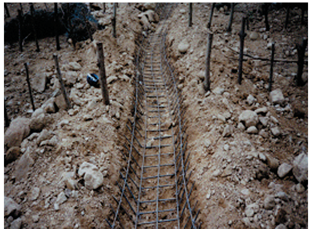
照片八 縱洩溝綁紮鋼筋
