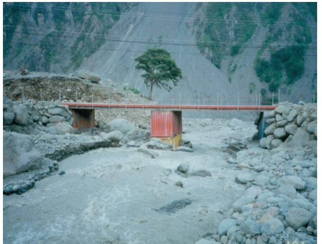
圖34 筆石橋第二階段鋼便橋
