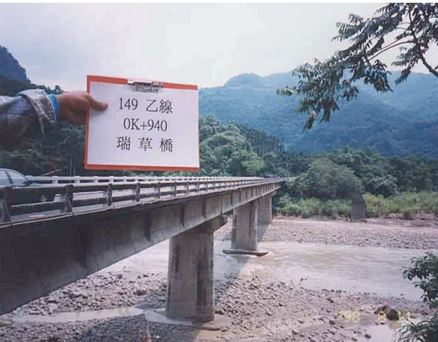
圖76 149乙線瑞草橋原橋照片
