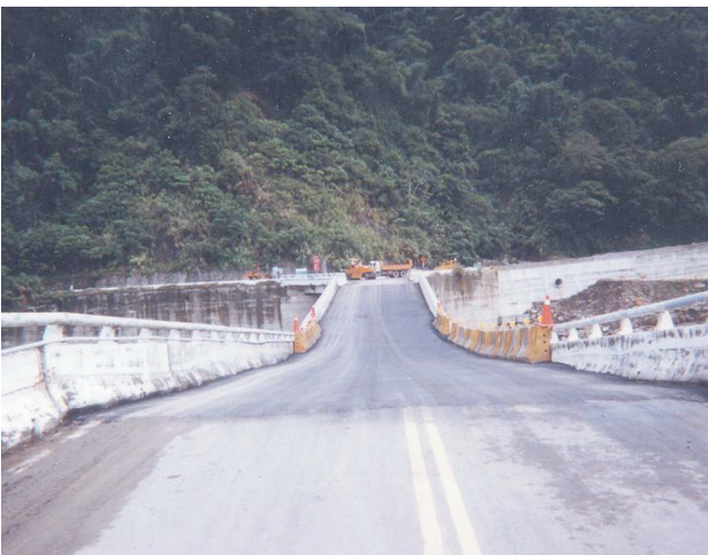
圖92 149甲線全仔社橋橋面以碎石料及AC調整縱坡
