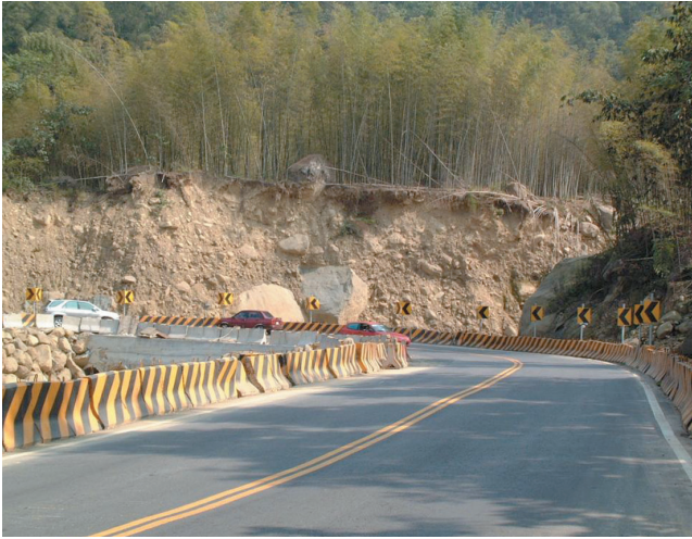
圖54 151線奮鬥橋便道便橋
