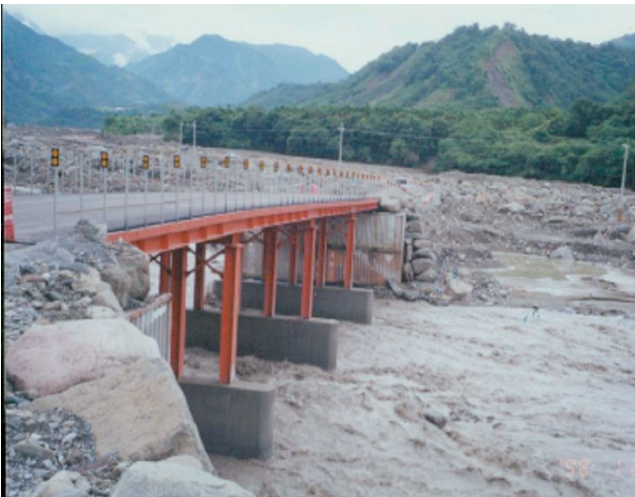
圖33 台21線陳有蘭溪橋第二階段鋼便橋
