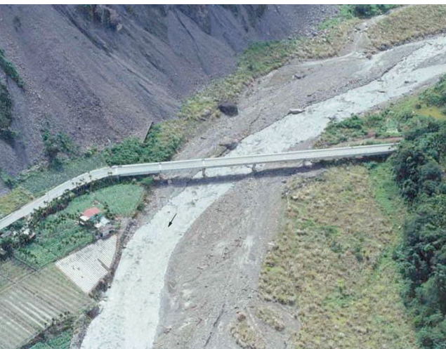
圖23 台21線陳有蘭溪橋原橋照片(空照)
