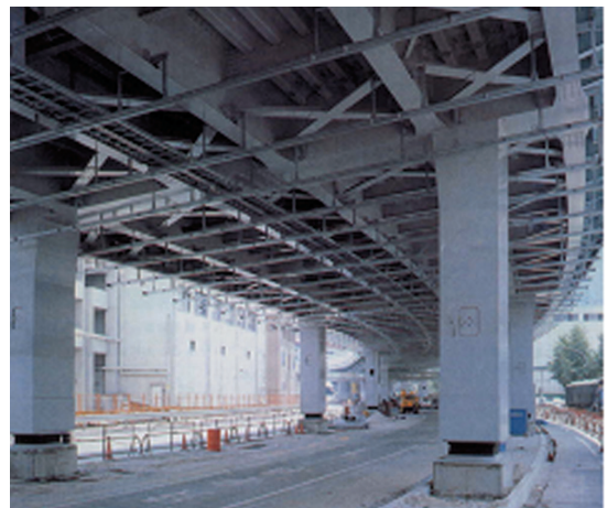
圖8 隔震支承應用於立體構架橋柱基部
