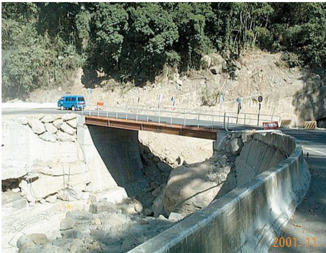
圖82 149甲線內湖橋搶修鋼便橋
