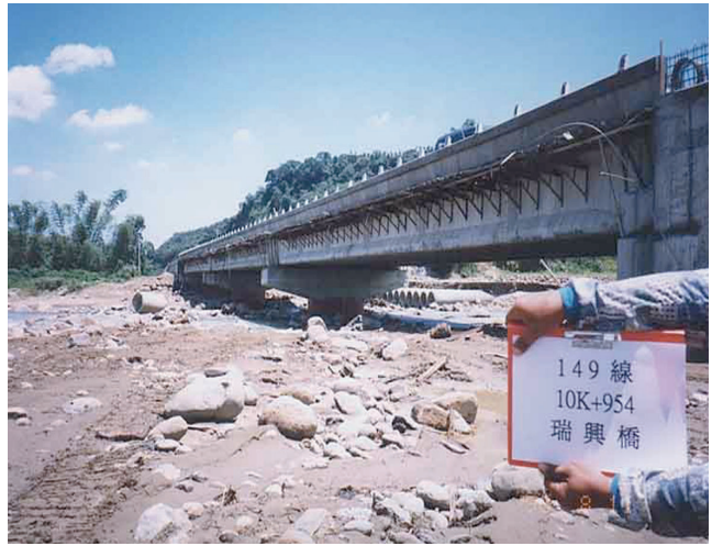
圖71 149線瑞興橋原橋照片
