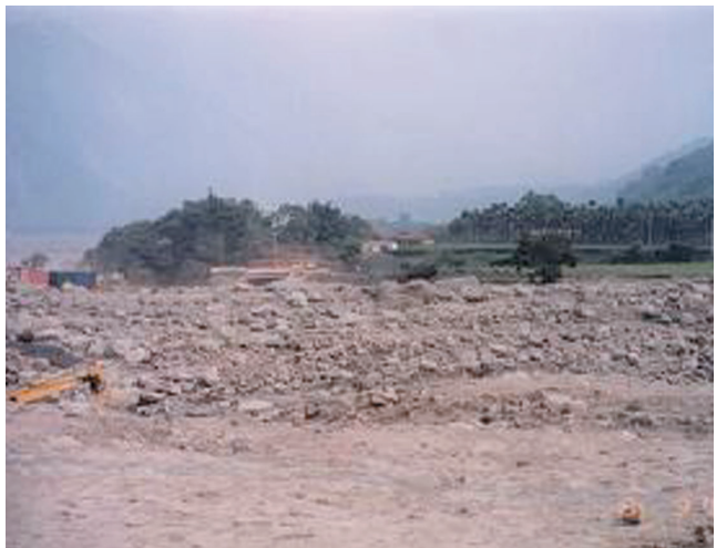
圖30 筆石溪沖積扇、堤防及路基均遭土石流沖毀流失，河床改道
