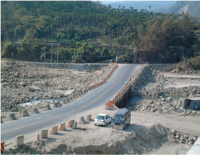
圖78 149乙線瑞草橋便道便橋
