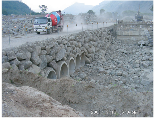
圖32 筆石橋遭土石流沖毀後以便道搶通
