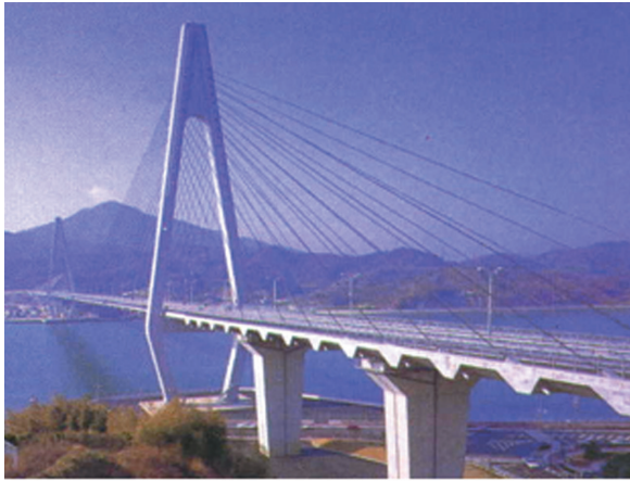
圖6 鋼梁與預力混凝土梁之混合構造 (3)
