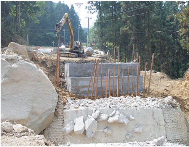
圖70 151線大仁橋復建工程A2橋台施工
