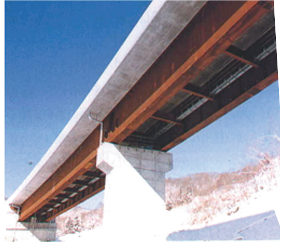
圖1 四主梁橋與二主梁橋之比較及二主梁橋施工完成圖
