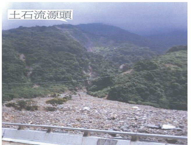
圖16 台21線十八重溪橋土石流源頭
