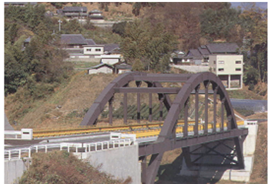
圖 14 耐候性鋼材防蝕安定化處理，與當地地景甚為融合。
