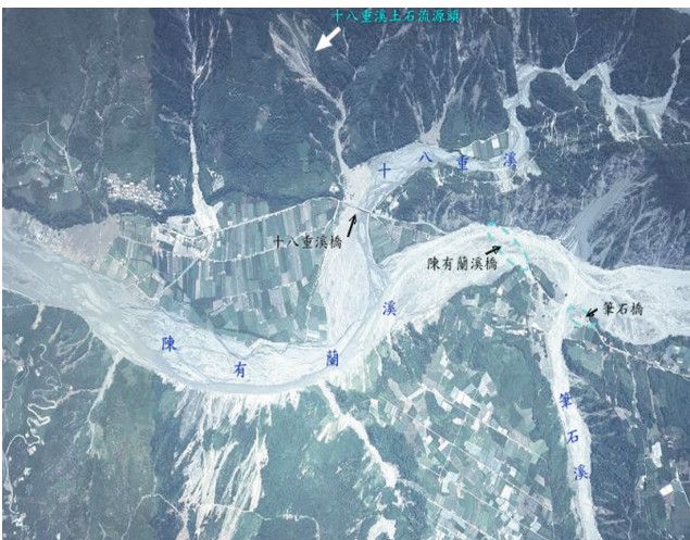
圖15 十八重溪橋土石流源頭及陳有蘭溪橋、筆石橋土石流災損照片(航照)
