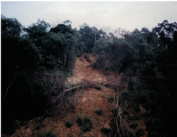
照片一 施工前邊坡
