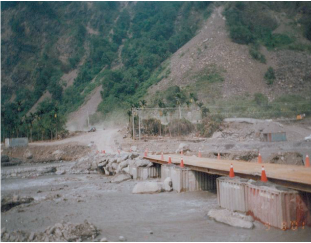
圖31 台21線陳有蘭溪橋第一階段便道及便橋
