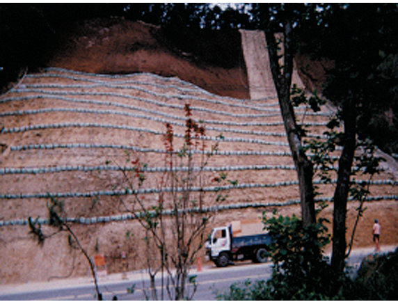
照片十一 上層坡面噴植生基材、鋪稻草蓆
