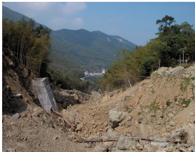
圖63 151線大孝橋溪槽遭土石流沖刷擴大(圖為復建工程A2橋台施工)
