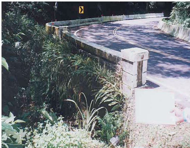
圖61 151線大孝橋原橋照片
