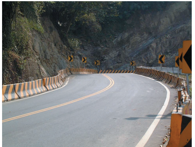
圖59 151線尚進橋便道便橋
