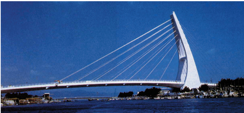
圖6 鋼梁與預力混凝土梁之混合構造 (2) (鈞竿型複合結構斜張橋完成圖)
