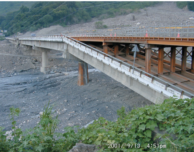
圖21 十八重溪橋塌落之橋面上架設鋼便橋
