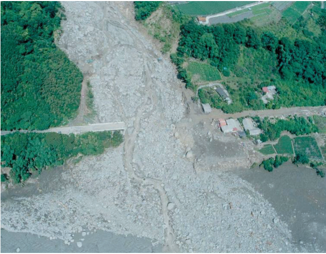
圖36 台21線望鄉橋遭土石流沖毀情形(空照)
