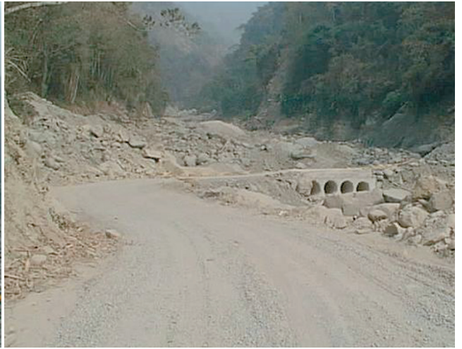
圖97 草瑞公路三龍橋便道
