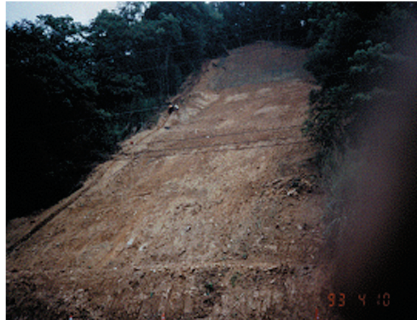
照片二 人工刷坡、坡面處理，挖縱洩溝
