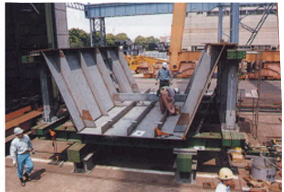
圖3 箱梁橋與開斷面箱梁橋之比較及開斷面箱梁橋施工圖
