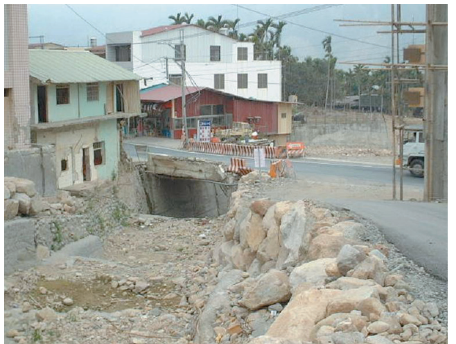
圖06 上安橋搶通後情形
