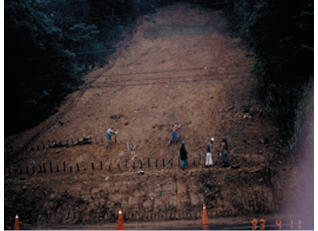
照片四 下層平緩處打木樁
