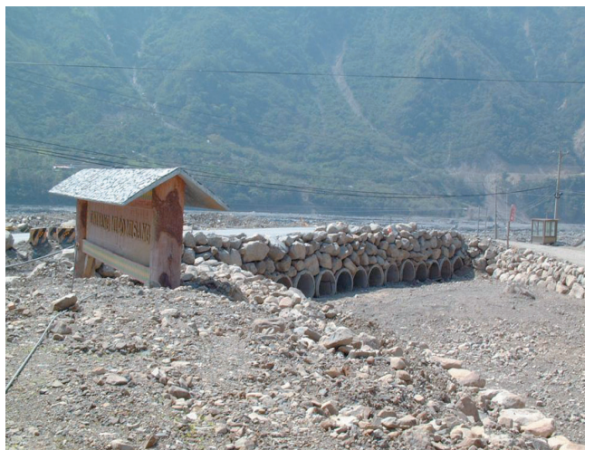
圖105 台16線地利橋涵管便道
