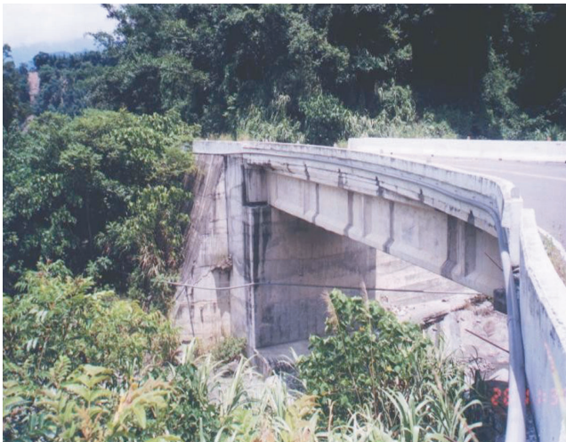
圖94 草瑞公路三龍橋原橋照片
