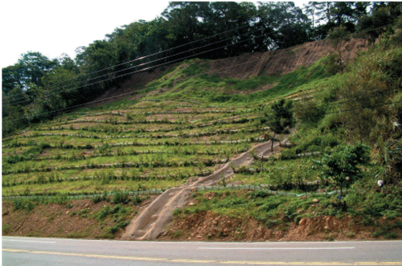
照片十三 完工二個月後，坡面植生草種生長茂盛
