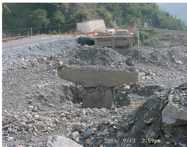
圖11 台21線信義橋於桃芝颱風後以河底便道搶通
