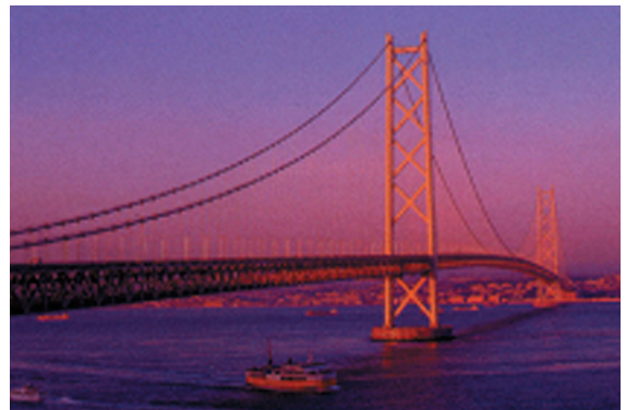
圖11 世界第一長三跨連續鋼桁吊橋（明石海峽大橋、中間跨距1991m）
