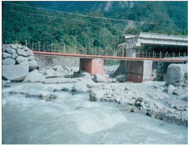
圖39 台21線望鄉橋便道便橋
