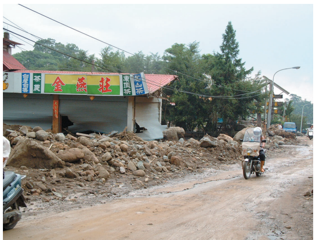
圖113 土石流躍上道路、橋面造成房屋損毀
