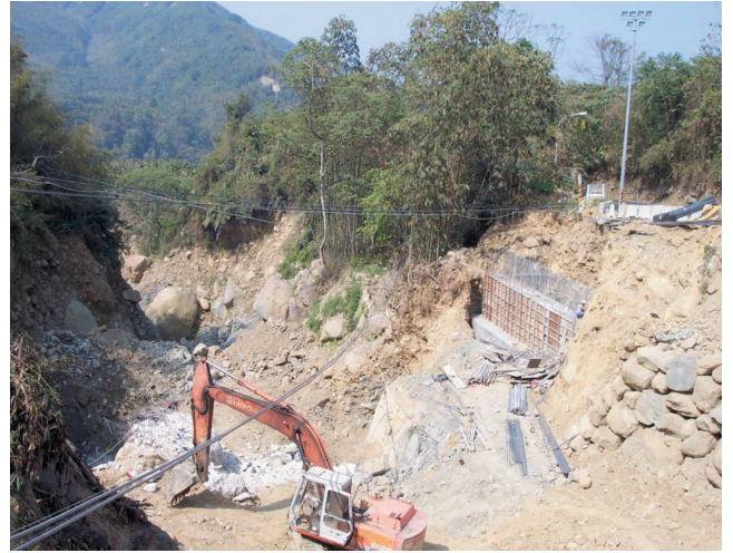
圖55 151線奮鬥橋採加長跨徑復建(A1橋台施工)
