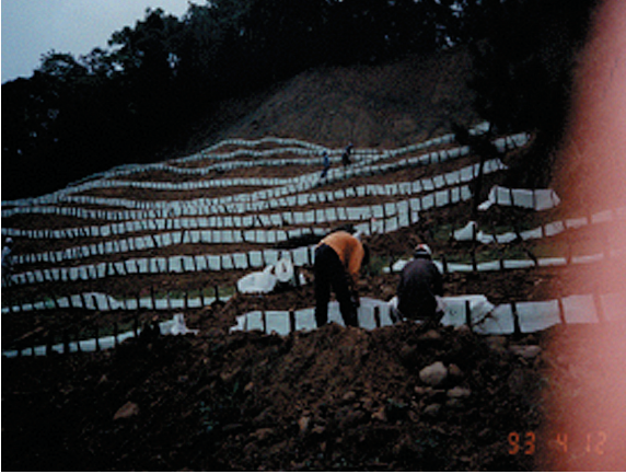
照片九 下層打樁面以不織布及網層編柵
