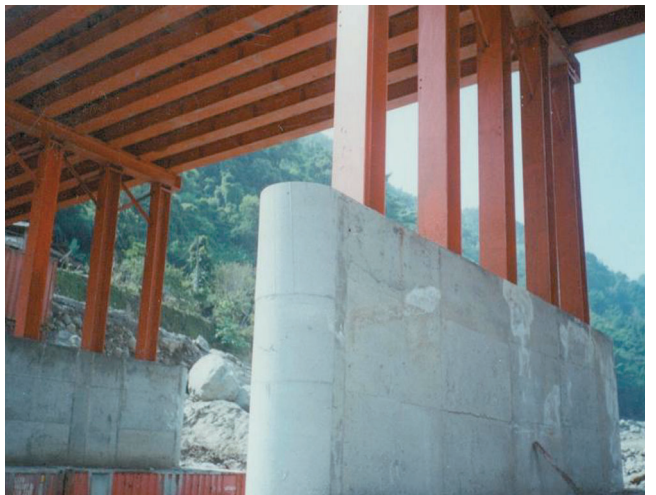
圖47 台21線松泉橋、神和橋鋼便橋（臨時貨櫃橋墩基礎）
