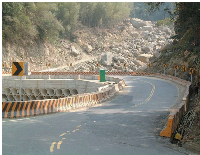
圖64 151線大孝橋便道便橋
