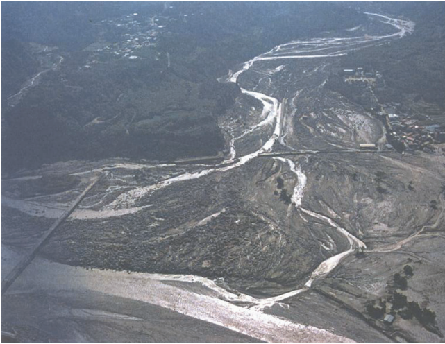
圖72 149線瑞興橋遭土石流沖毀(空照)
