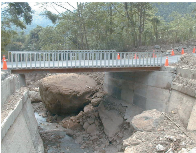
圖106 136線平和橋橋面沖損後以鋼便橋搶修
