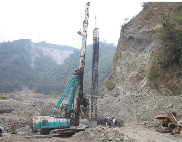
圖80 149乙線瑞草橋復建工程基礎改採全套管基樁
