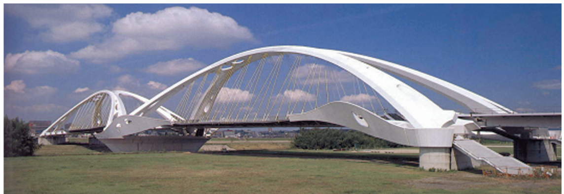
圖12 愛知縣豐田大橋，因位於河濱公園，橋梁主結構係仿動物骨骼設計，造形甚為獨特。
