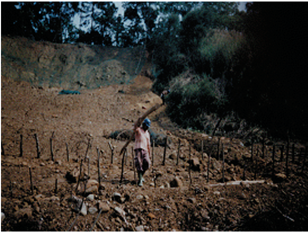
照片五 上層陡峭處鋪設立體網層
