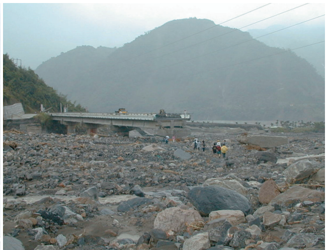
圖10 桃芝颱風後遭土石流沖毀之信義橋
