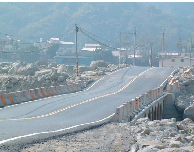
圖74 149線瑞興橋鋼涵管便橋
