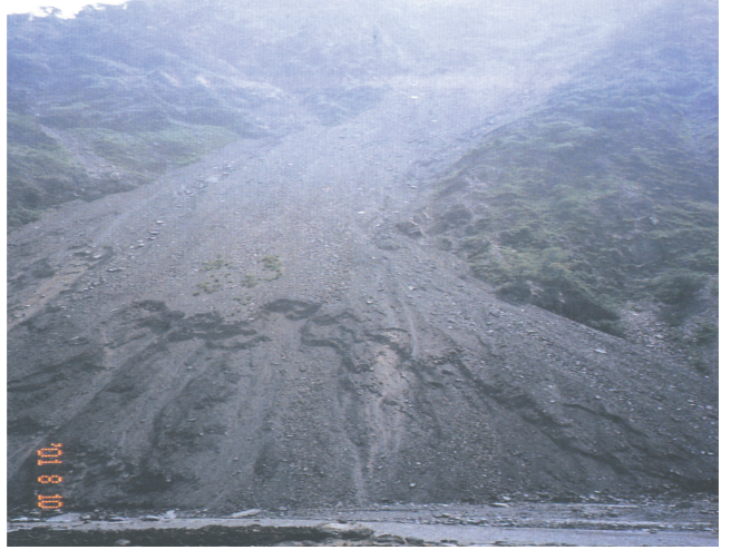
圖26 筆石溪匯流口對岸邊坡崩坍造成土石流來源之一部分
