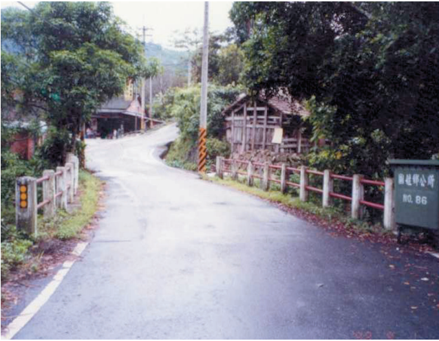
圖108 147線無名橋原橋照片
