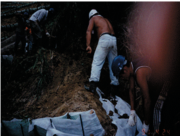
照片七 蝕溝鋪設不織布
