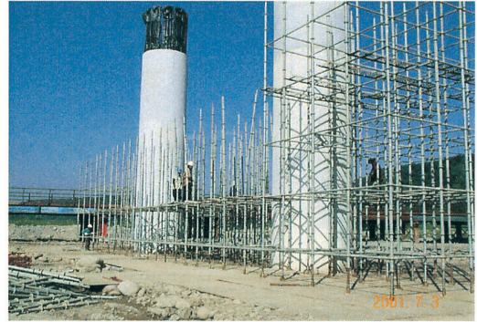
帽梁施工架組立
