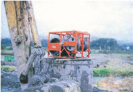
基樁深度及垂直度檢查
