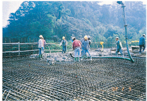
箱梁頂版混凝土澆注
