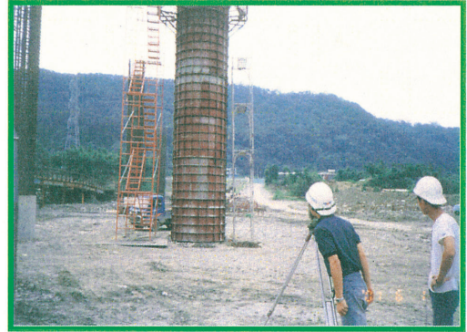
墩柱鋼模垂直度檢查
