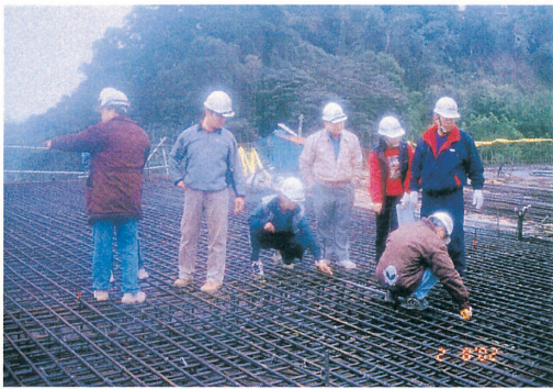
箱梁頂版鋼筋檢查
