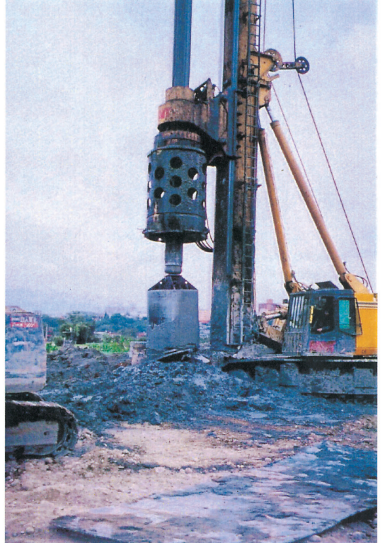
全套管基樁鑽掘
