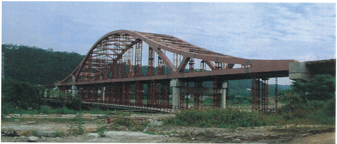
鋼橋吊裝完成 施工照片
