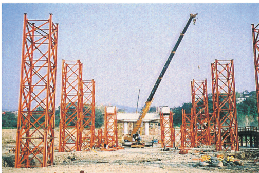
上部支撐架吊裝
