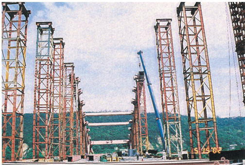
下部支撐架吊裝
