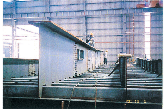
鋼床板U肋與橫梁架設
