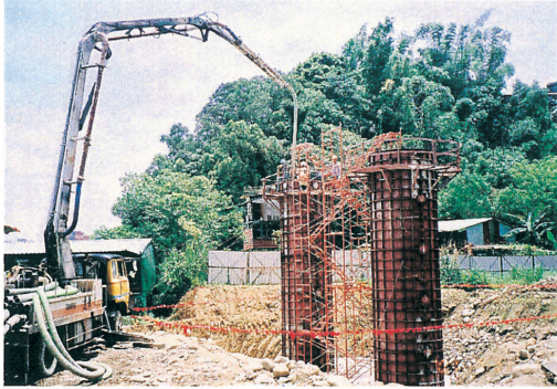
墩柱混凝土澆注
