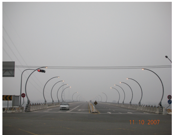
照片 50 里嶺大橋改建後
