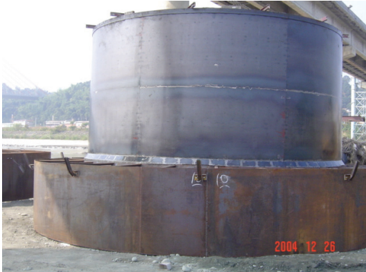
照片 11 沉箱鐵腳定位及內模組立
