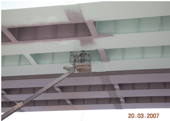
照片 31 鋼箱梁表面塗裝
