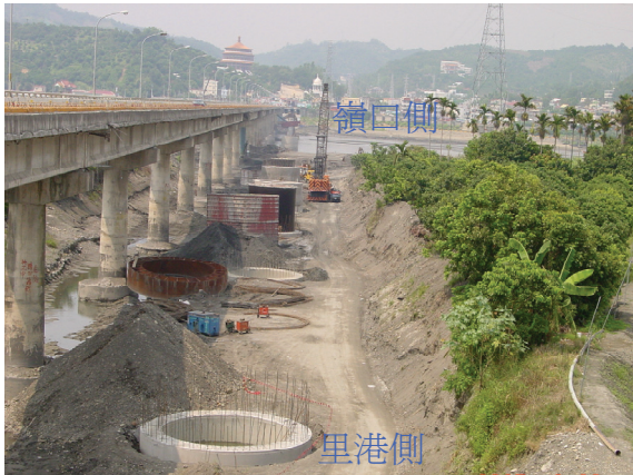
照片 35 非汛期施工全景
