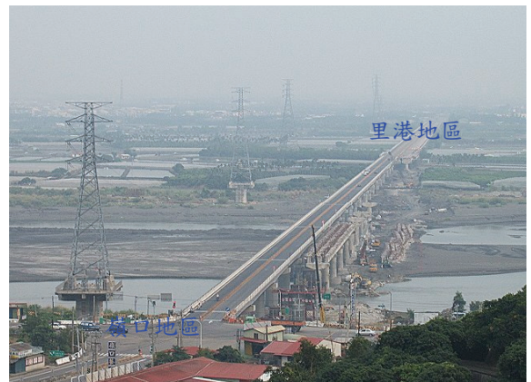
照片 10 下游側拆橋後全景照
