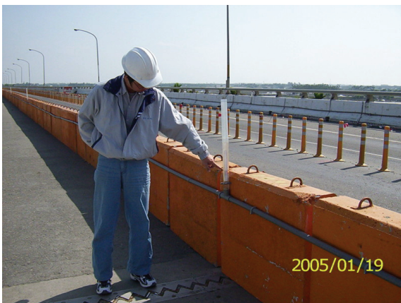
照片 33 聯通管觀測水位
