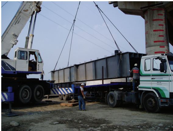
照片 43 鋼箱梁拆解運回鋼構廠
