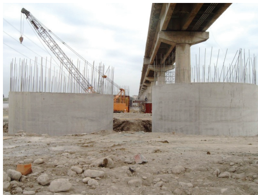
照片 18 上下游側沉箱同時施工
