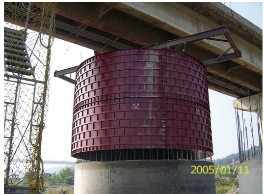
照片 14 沉箱外模拆除
