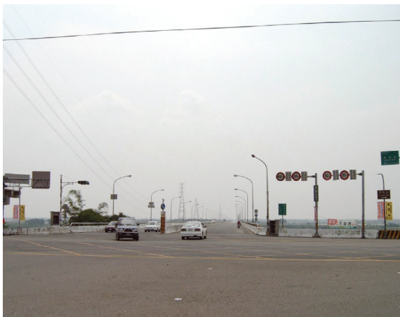
照片 49 里嶺大橋改建前
