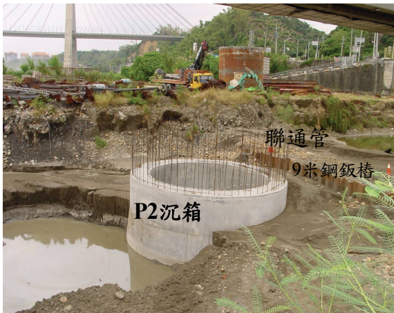
照片 47 沉箱、聯通管及鈹樁間現況
