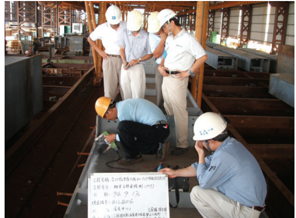
照片 46 鋼箱梁銲道及外觀等檢測
