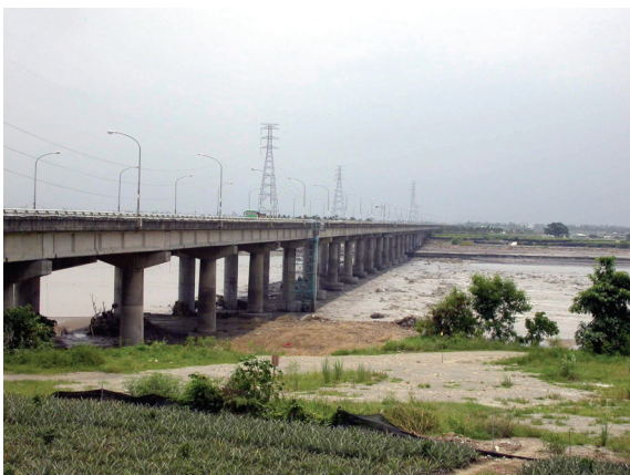
照片 1 里嶺大橋原橋下現況
