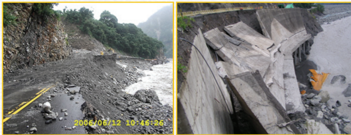
圖 3-12 河（溪）流沖蝕道路損壞情形。（照片來源：二工處谷關段、三工處甲仙段）
