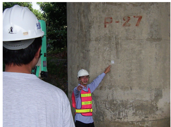
照片 34 墩柱結構物變位量收測
