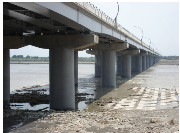
照片 24 墩柱帽梁完工照
