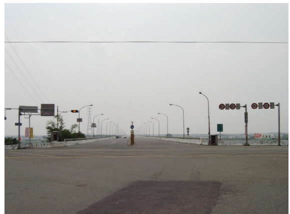
照片 2 里嶺大橋原橋上現況
