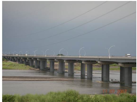
照片 32 鋼箱梁完成全景
