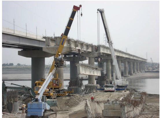
照片 8 下游側舊預力梁吊離作業
