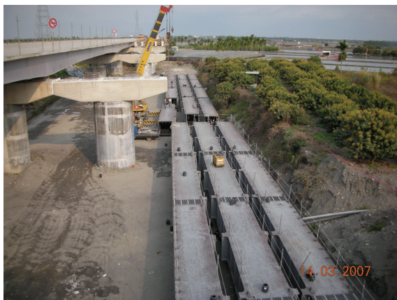
照片 29 鋼箱梁現地組裝
