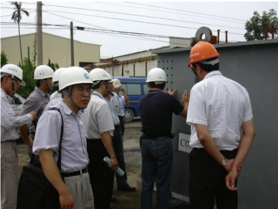
照片 45 總局工程司查核泡水鋼箱梁
