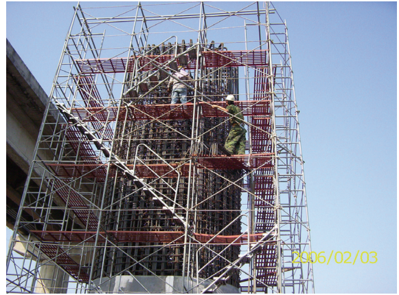
照片 20 墩柱第二層鋼筋綁紮
