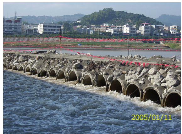
照片 4 施工便道及排水現況
