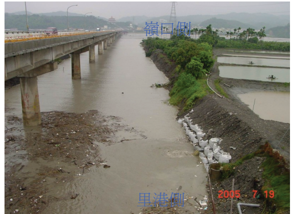
照片 36 94年汛期全工區淹水(一)
