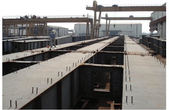
照片27 鋼箱梁假安裝檢
