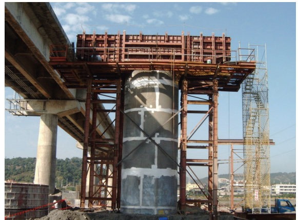
照片 22 帽梁支撐架全景
