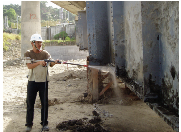
照片 42 鋼箱梁扶正清洗檢視
