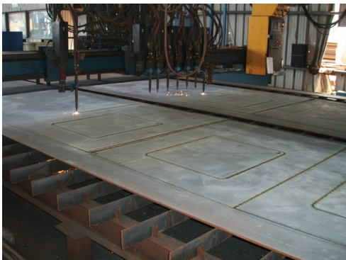
照片 25 鋼箱梁劃線
