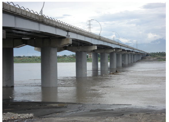
照片 52 里嶺大橋改建後橋基
