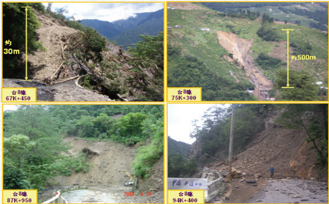
圖 3-2 道路上方邊坡滑動。(照片來源：二工處谷關段)
