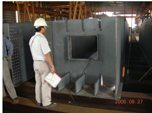
照片 26 鋼箱梁組立
