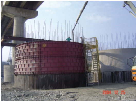
照片 13 沉箱混凝土澆置
