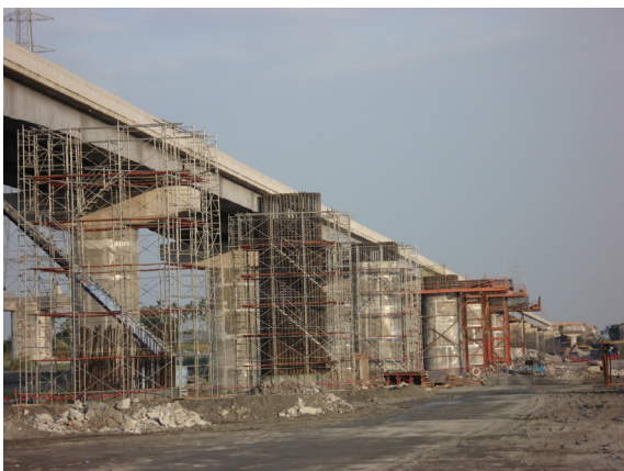
照片 23 墩柱帽梁施工全景
