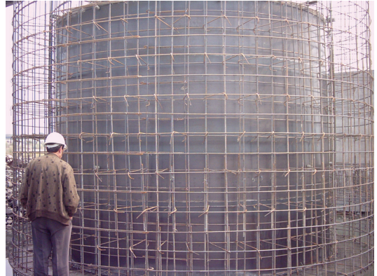
照片 12 沉箱鋼筋綁紮
