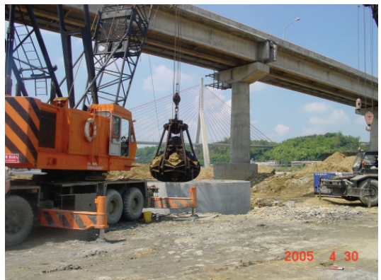
照片 16 沉箱下沉施工(受限淨高不足)
