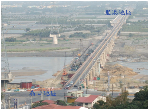
照片 9 上游側拆橋後全景照
