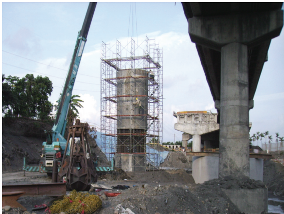
照片 21 墩柱防撞鋼板安裝
