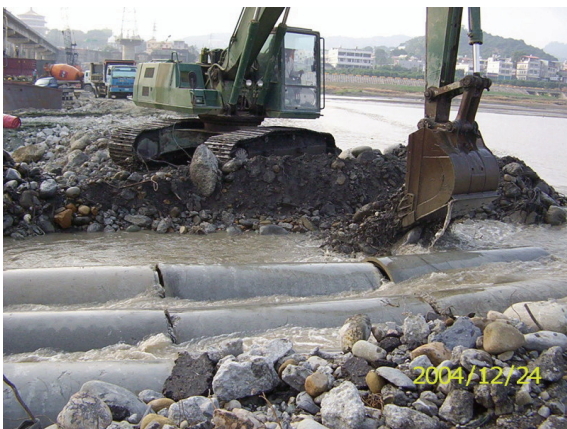
照片 3 施工便道管涵鋪築中
