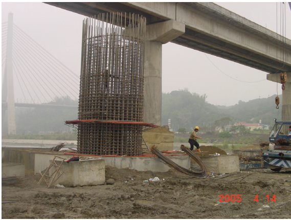
照片 19 墩柱第一層鋼筋綁紮
