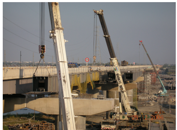
照片 30 鋼箱梁吊裝作業
