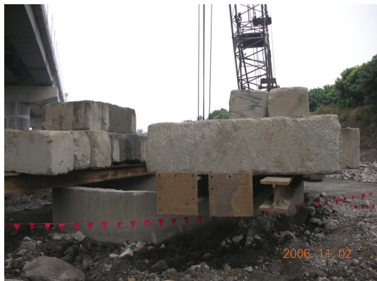
照片 17 沉箱下沉配重施工
