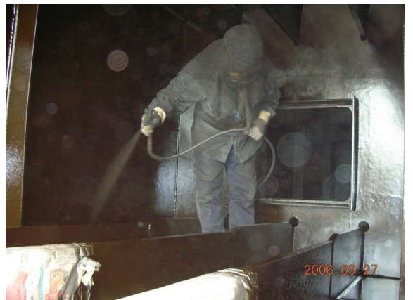
照片28 鋼箱梁工廠內塗裝作
