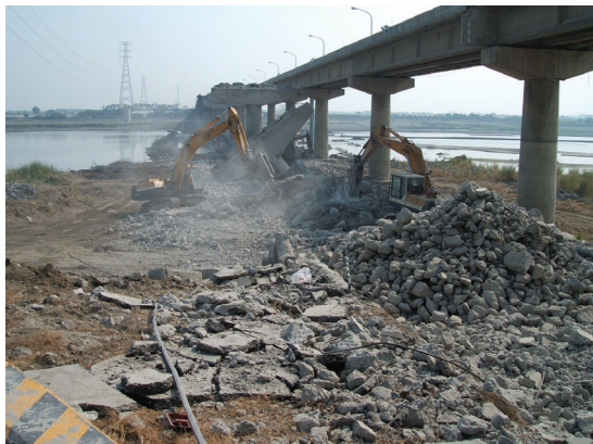
照片 7 上游側拆橋作業
