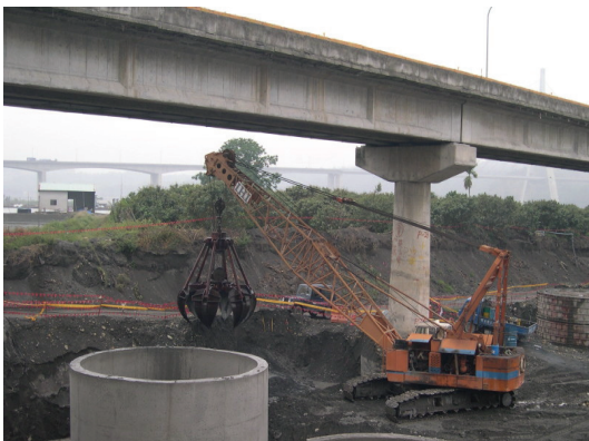
照片 15 沉箱抓土下沉施工
