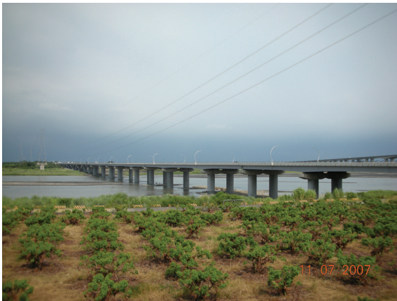
照片 53 里嶺大橋改建後全景(一)
