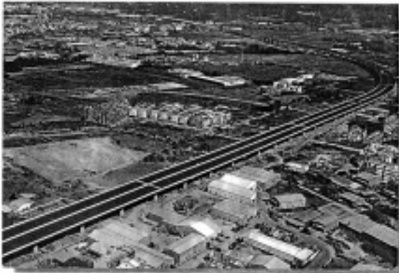
高雄支線 C393Z 標高架橋完工全貌
