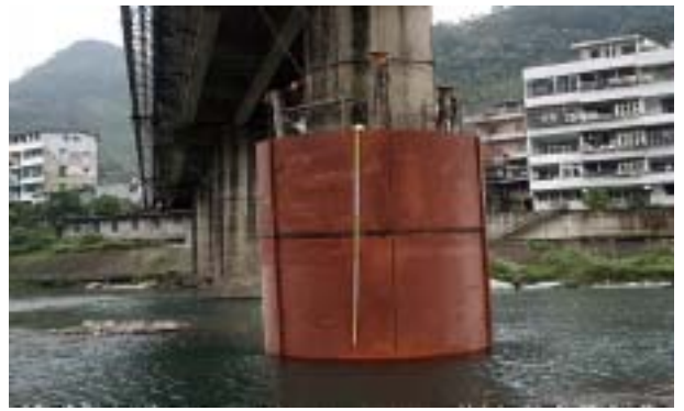
照片 1 鋼鈹吊放作業
