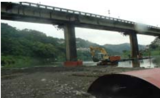
照片 6 鋼鈹吊放作業完成
