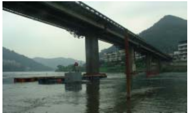
照片 3 泵送水中無收縮水泥
