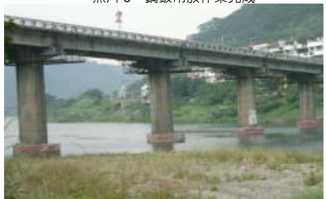
完工後現況照片 (92.10.23)
