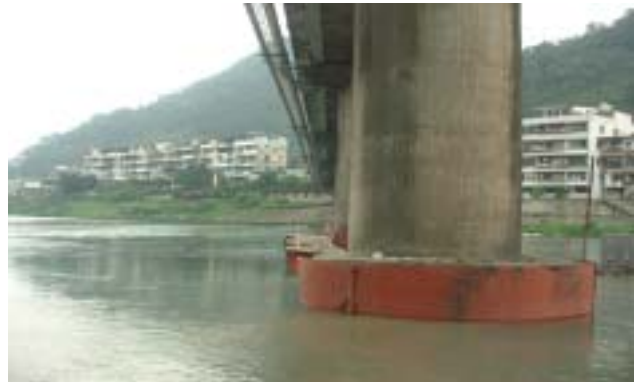
照片 5 鋼鈹吊放作業完成
