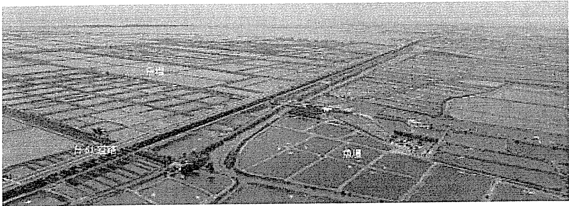
圖 3.7-1 北側台 61 高架道路
