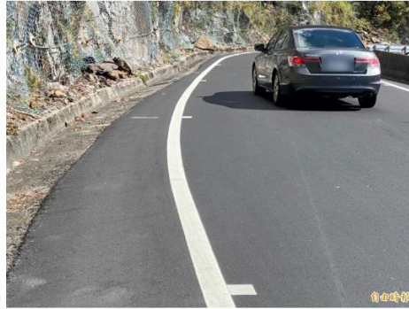
公路總局埔里工務段最近進行台14甲線翠峰至昆陽路面改善工程，在一般道路反光標線旁再增設成型反光標線。(記者佟振國攝)
