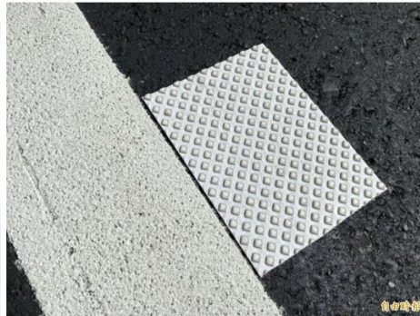
成型反光標線遠觀看似平滑，其實表面佈滿顆粒，除了增加車輪磨擦，不隆起於路面，也維護機車、自行車騎士安全。(記者佟振國攝)
