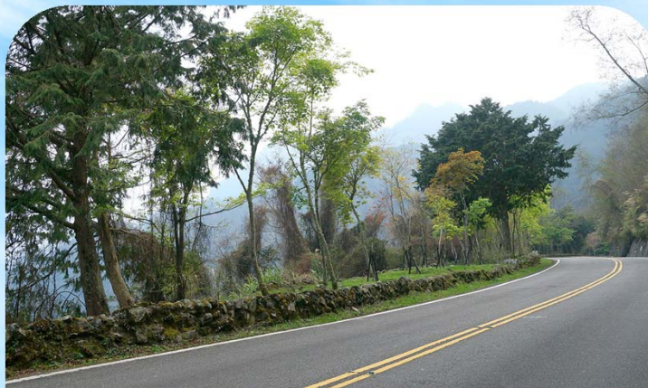
■ 137K+200民國96年施作砌石花台現況
