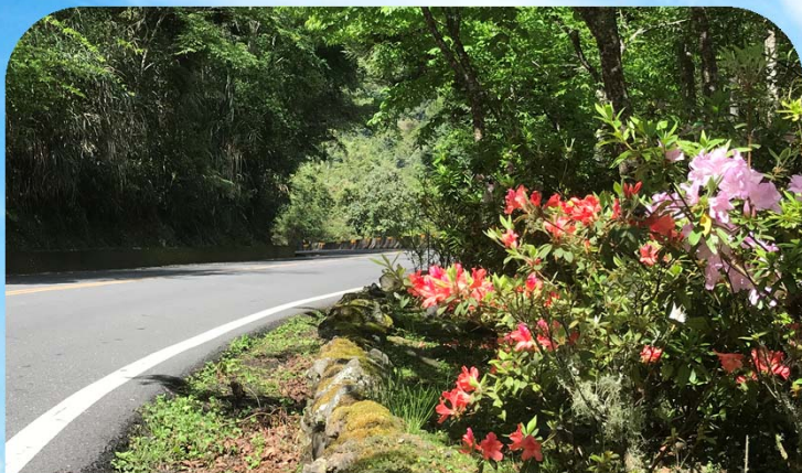
■ 129K+800民國102年施作砌石花台現況
