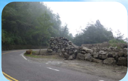
■ 127K+200 坍土暫置區施工前
