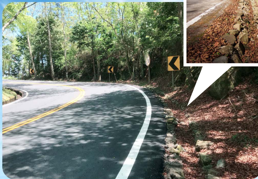
■ 改善後 138K+300 邊溝石塊修繕
