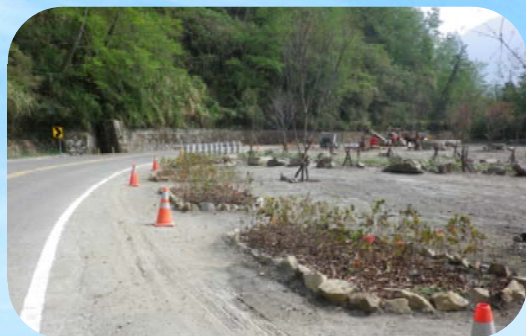
■ 隙地改善施工中
