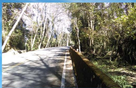
■ 改善前 136K 舊有護欄減量
