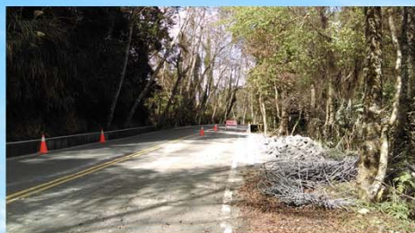
■ 施工中 136K 舊有護欄拆除
