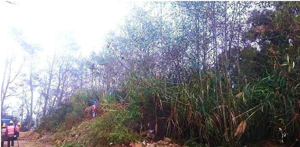
↑ 施工前：雜木及雜草蔓生
