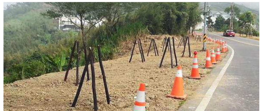
整地、支架及樹穴回填完成
