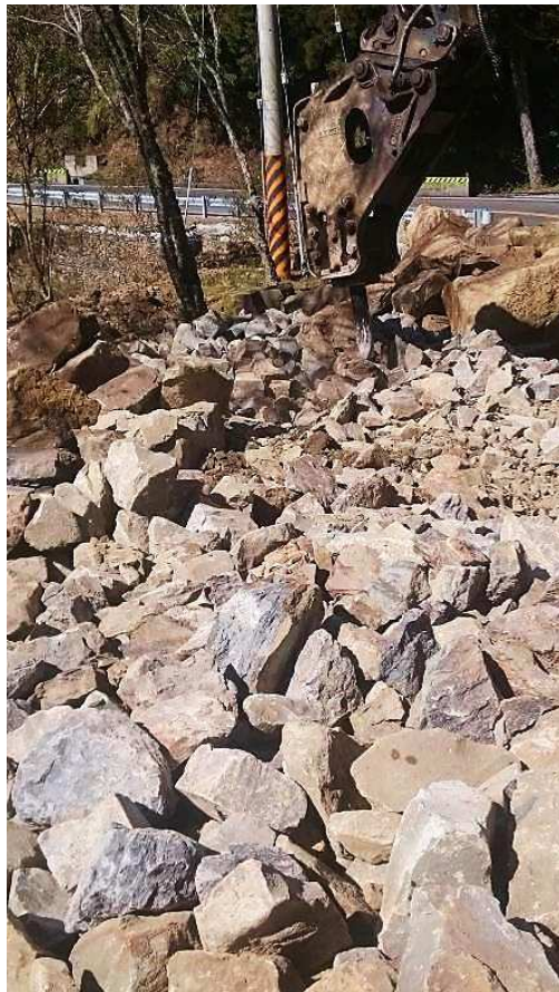
孤石破碎作業
